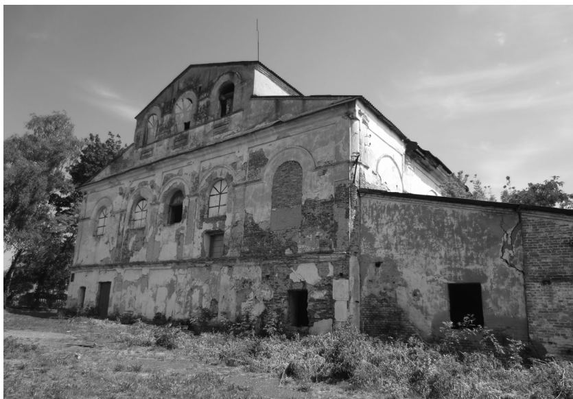
Здание бывшей синагоги в Кобрине. Август 2015 г. Фото К. Гавриленко
